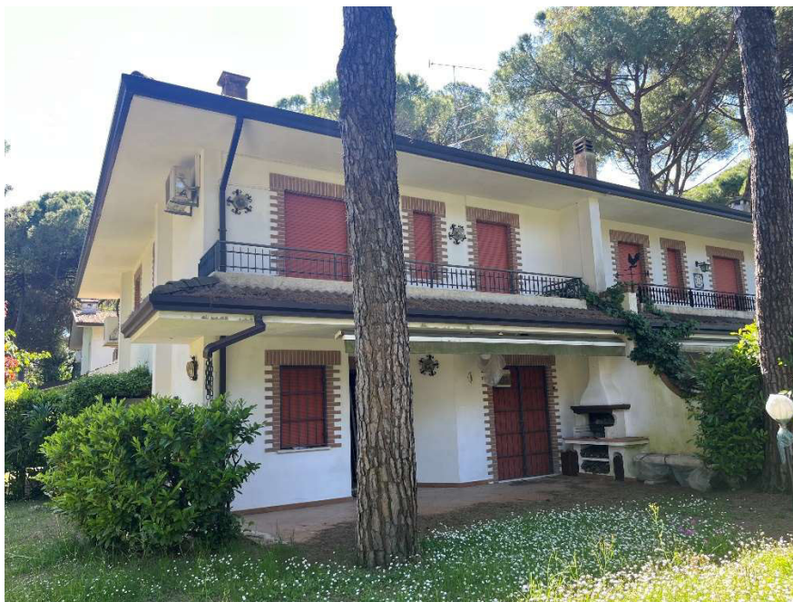
FOTO 1: FACCIATA PRINCIPALE FABBRICATO
